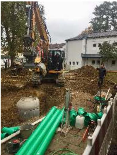
Sie waren undicht, was zu Unterspülungen des Geländes und Überschwemmungen in den Gebäuden führte.
